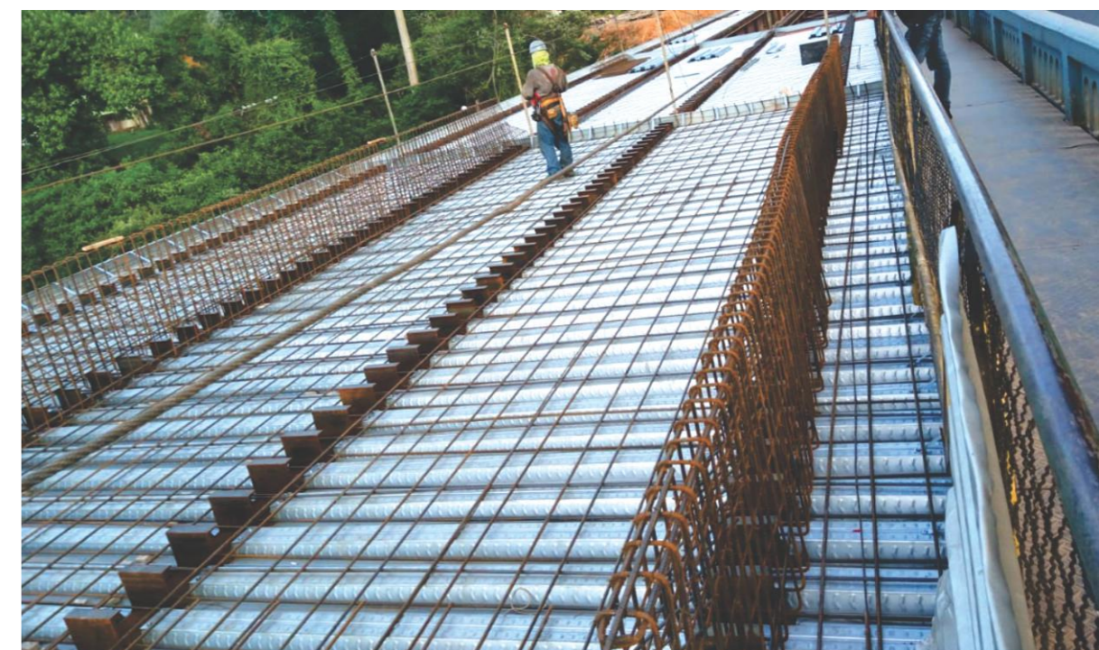
Ponte | Rio das Velhas - MG
